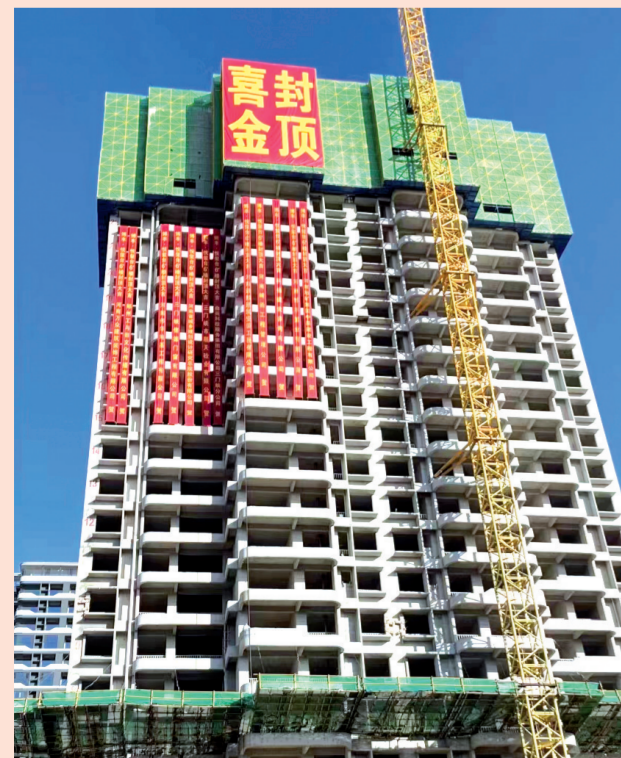
6号楼喜封金顶
