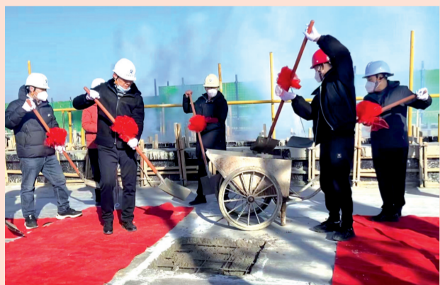
博丰领导浇筑最后一方混凝土
