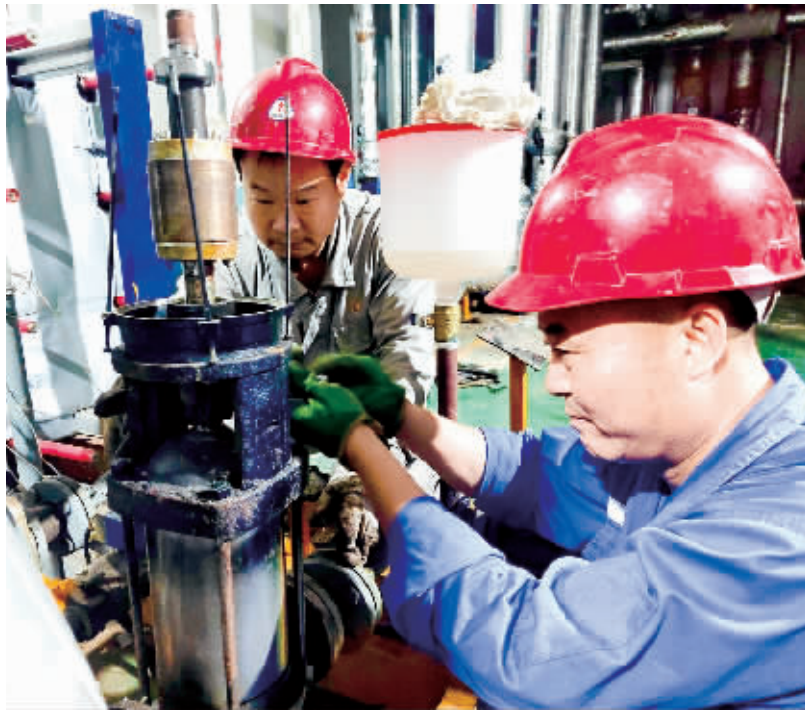
我市热力企业工作人员正在进行供热设备检修
