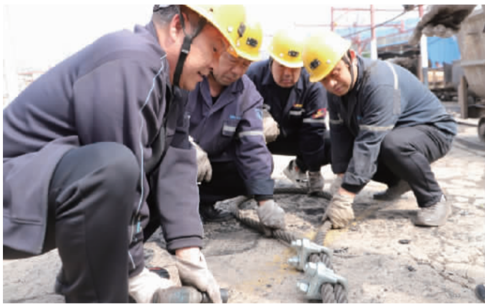
春日奋进正当时,生产一线干劲足。近日,义煤公司常村煤矿运输队职工精心维护运输设备钢丝绳,严把质量安全关,全力保障设备平稳运行,以实干担当助力生产高效推进。图为日前,运输队职工在更换钢丝绳绳卡。 闫乐乐 摄影报道
