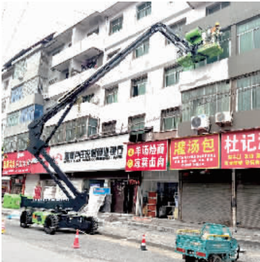
近日，卢氏县为居民楼加装保温材料，用心用情用力办实事，让老百姓过上“暖冬”。图为该县城关镇西大街施工场景。
