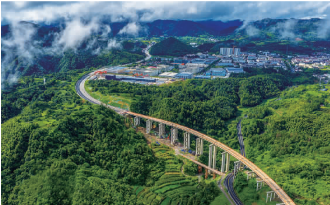
7月28日,浙江省绍兴市新昌县104国道新昌段改建工程项目建设现场,施工人员抢抓工期,全力推进桥梁上部结构施工作业等各项工作。
