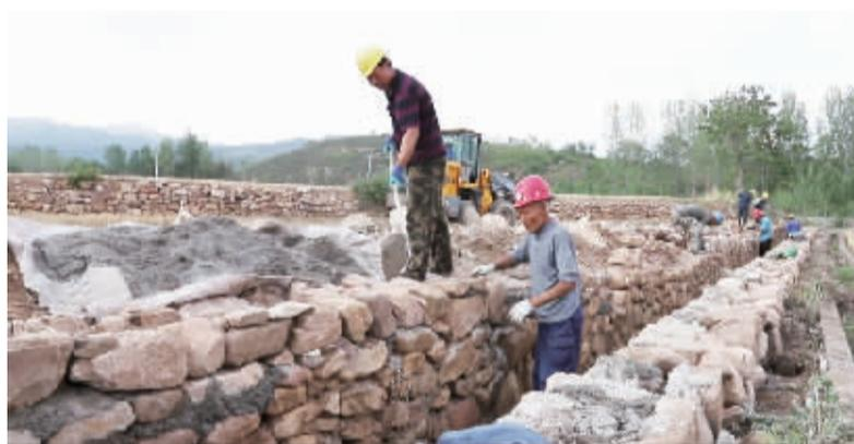
排水渠。6月初,大水沟村排水渠清淤加固工程正式开工。施工队采取分段施工的模式进行清淤疏通、结构加固,在原有渠道80公分基础上加高40公分,累计使用浆砌石500立方、
