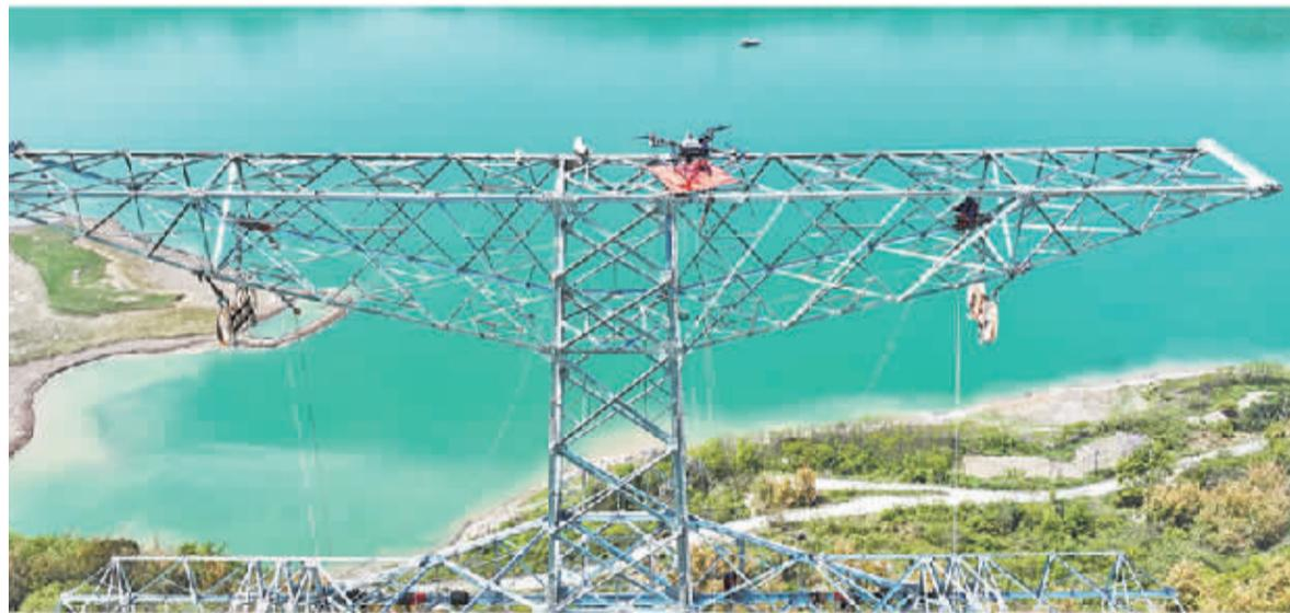
4月7日,重庆市万州区长江边,“西电东送”重点工程金—湖北±800千伏特高压直流输电工程开始跨江作业。据了解,这是西南地区首次应用大载重无人机参与特高压工程放线作业。据了解,这是西南地区首次应用大载重无人机参与特高压工程放线作业。据影像中国
