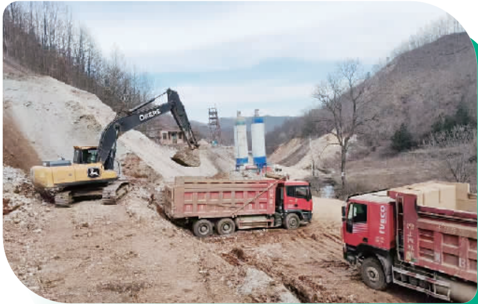
卢氏县寺合院锑矿区废井封井回填示范项目正在紧张施工
