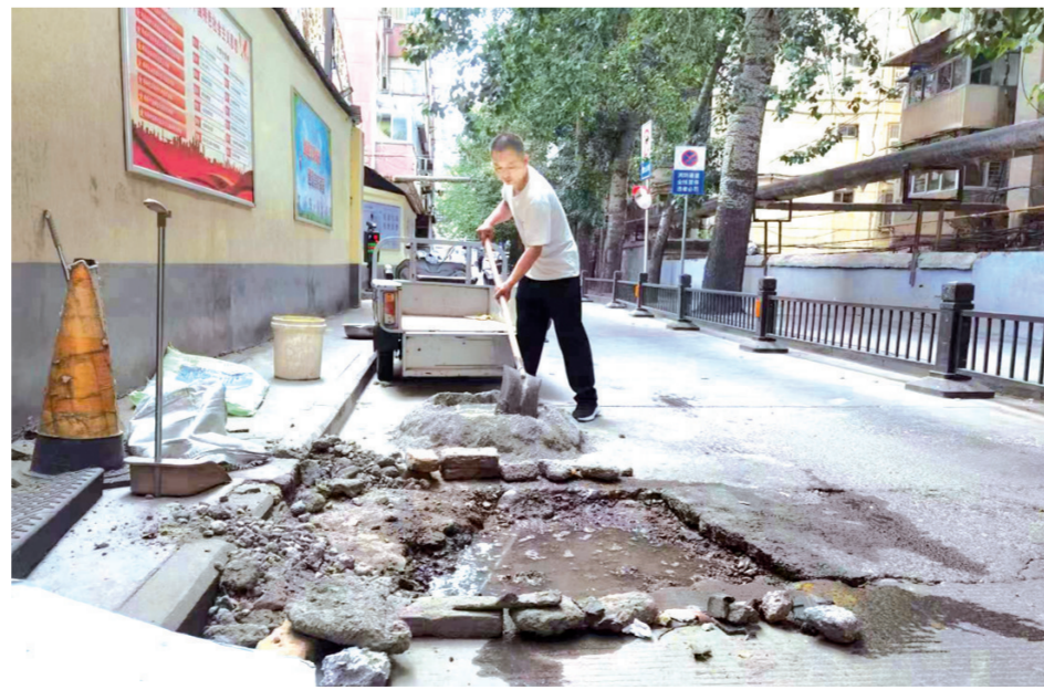
修复破损路面 消除安全隐患
