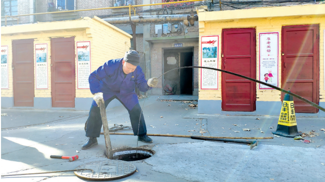
工作人员在疏通管道 程倩 摄
